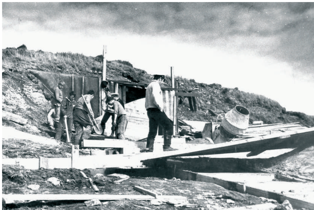
Илл. 185. Строительство мемориала на горе Северной. СККМ
