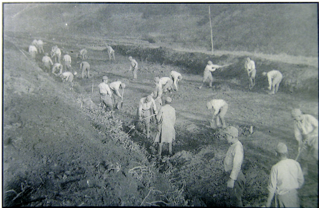
Илл. 16. Строительство дороги Катаока – мыс Кокутан. История войны. Операции армии северо-восточного направления (на яп. языке)
